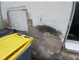
Humidité importante en bas des murs à l'extérieur
